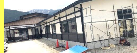
笑楽の増築工事は順調に進んでいます。乞うご期待
